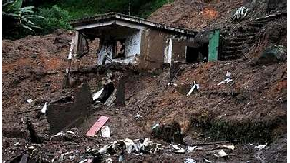
Κατοικία στην γειτονιά Campo Grande της Τερεσόπολης
